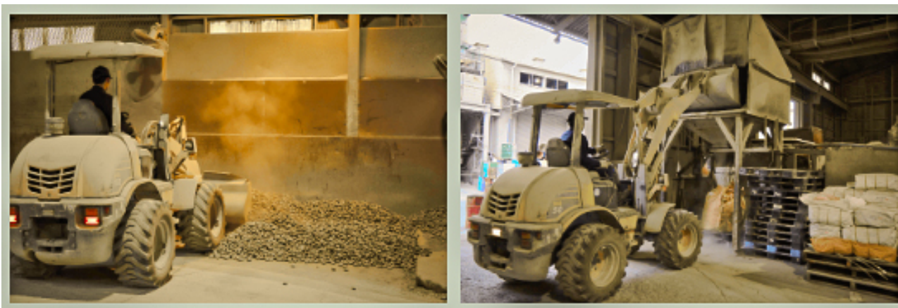
団鉤設備の内部
